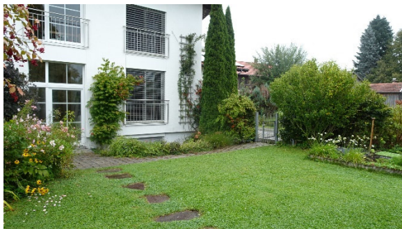
Abb. 2 Garten mit Bestandsgebäude Nr. 34a
